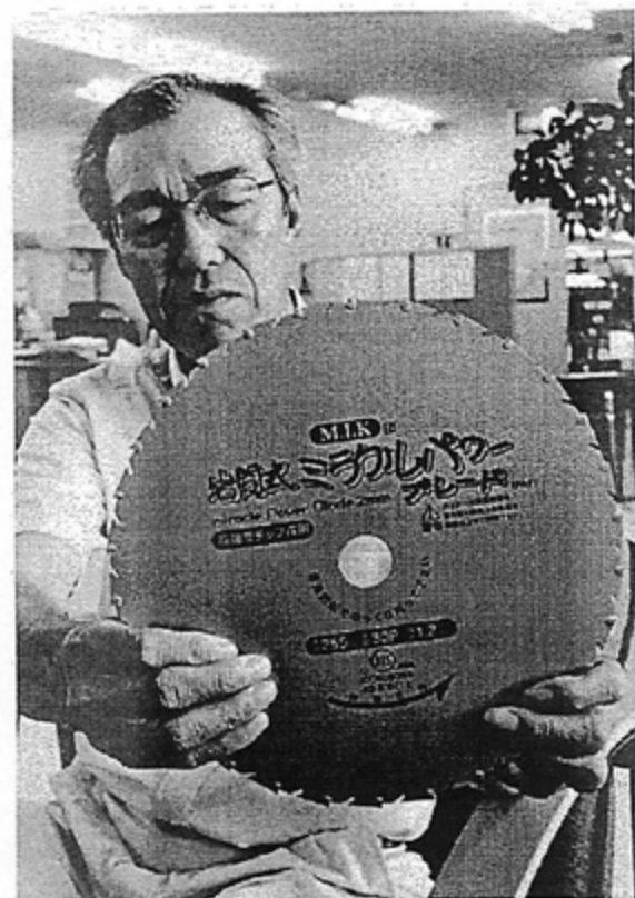
低速回転での草刈り作業を実現した岩間式ミラクルパワーブレードを持つ岩間さん(岩手県花巻市で)
